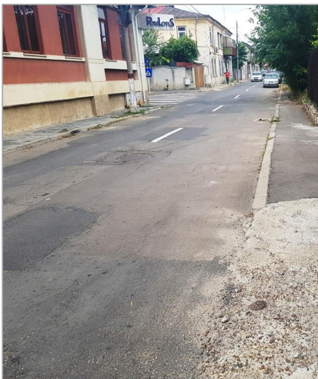
Figura 2.29. Străzi a căror suprafață de rulare se află în stare tehnică proastă (Exemplificare).
