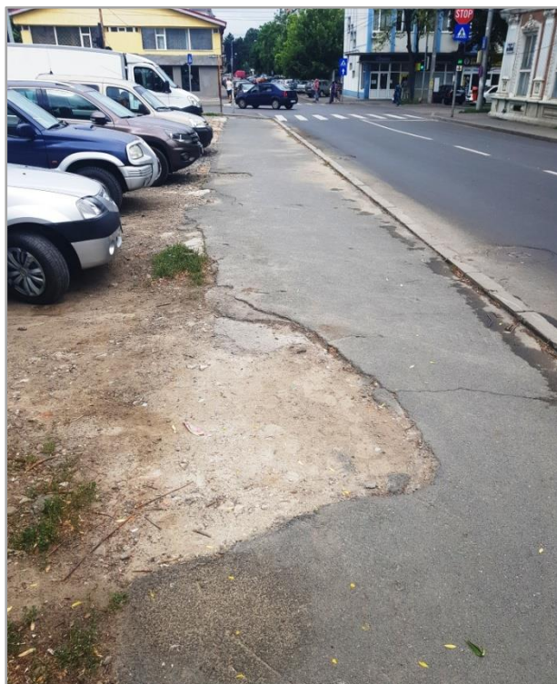
Figura 2.76. Trotuare în stare necorespunzătoare (Exemplificare).
