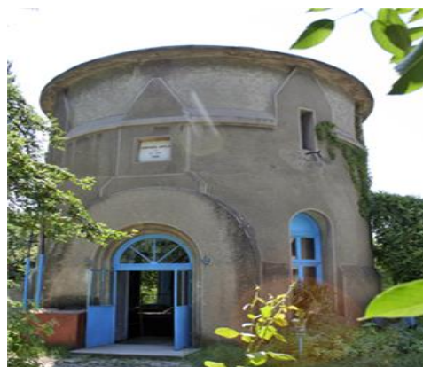
SCADA Turnul de apa (foto 8)
