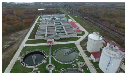
Stația de epurare ape uzate Galați (panoramă) 49
