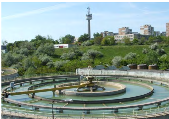
Uzina de apă nr 2-Decantor (foto3)
