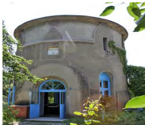
SCADA Turnul de apa (foto 8)
